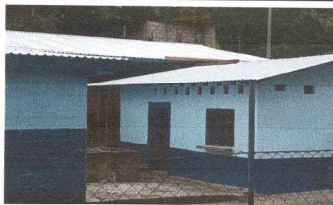
Foto 5: Ejecución completa de los renglones de lámina troquelada calibre 26 y mantenimiento de estructura de techo en el módulo de la cocina.
