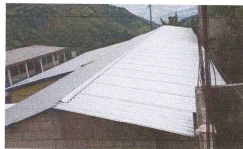
Foto 2: Vista desde otro ángulo del módulo 1 con la instalación completa de lámina troquelada calibre 26.
