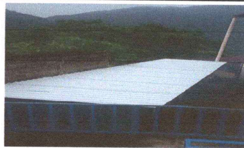
Foto 6: Renglón de cubierta de lámina ejecutada con la instalación de lámina troquelada calibre 26 en el área sanitaria para niños y niñas.
