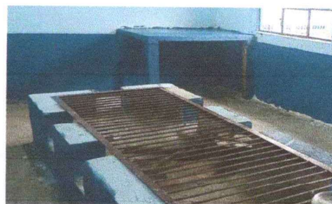
Foto 4: Ejecución de los diversos renglones de trabajos para un adecuado remozamiento del área cocina.
